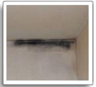
L'origine del vapore acqueo è da ascrivere al processo di respirazione degli abitanti, alla "produzione interna" di vapore delle cucine e dei bagni, ecc. ed alla "restituzione" dell'acqua da parte dei muri.
